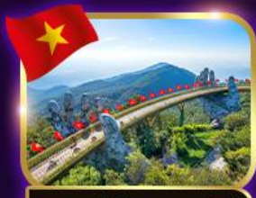
สะพานมือสีกอง บานาฮิลล์
